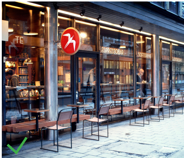
In de gevel geïntegreerde bankjes en tafeltjes, rustige vormgeving
